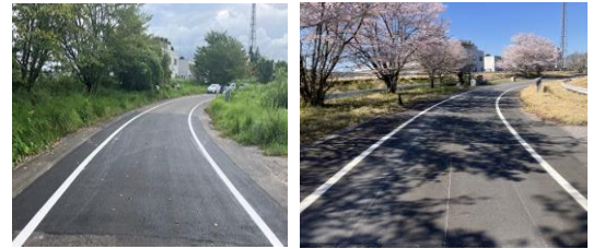
写真-1 施工完了直後(左)と30万輪載荷後(右)の路面状況
