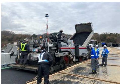
写真-8 橋面舗装での切削オーバーレイ工の事例
