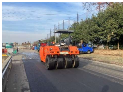
写真-3 バイオ炭アスファルト混合物の施工状況
