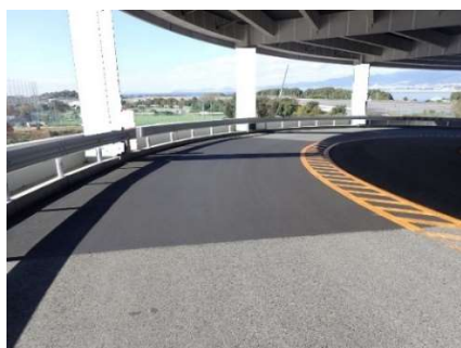
写真-6 施工完了状況
