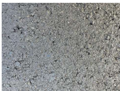
写真-4 施工完了後仕上がり
