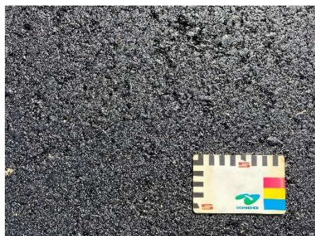
写真-6 施工完了後仕上がり
