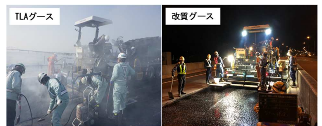
写真-1 施工状況写真(左:TLA グース右:改質グース)
