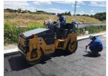
写真-3 転圧状況
