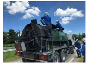
写真-2 添加剤投入状況
