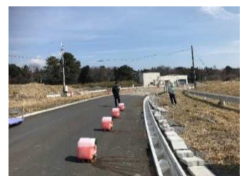
写真-5 散水試験状況
