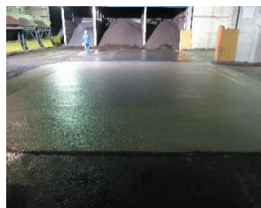
写真-9 施工完了状況
