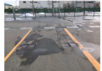
写真-7 施工前の状況
