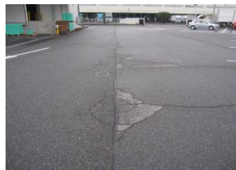
写真-4 施工前の状況
