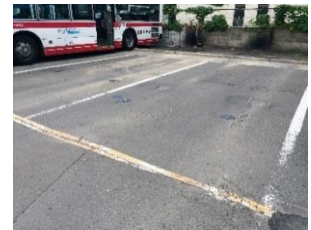
写真-12 施工前の状況
