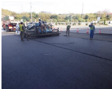
写真-5 施工状況
