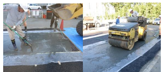
写真-1 開発品の施工状況
