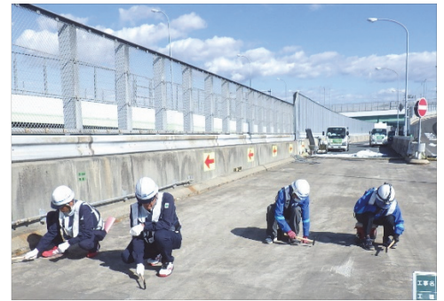
写真－1 RC 床版の打音検査の事例
