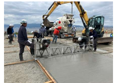
写真1 施工状況写真
