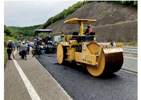
写真-2 施工状況
