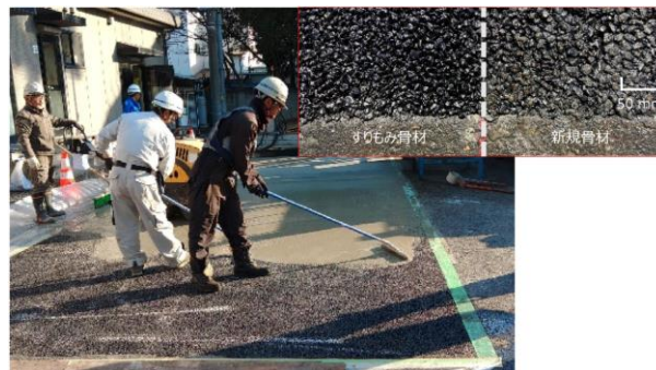
写真-2 試験施工の状況(右上:路面仕上がりの比較)
