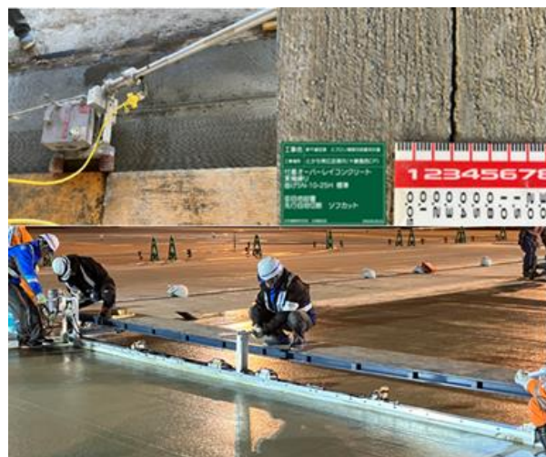
写真-2 縁切り目地施工法（上段：早期目地切断、下段：軽量振動目地切装置）
