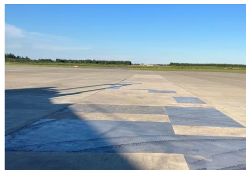
写真-1 エプロンの状況
