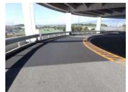
写真-1 施工完了状況
