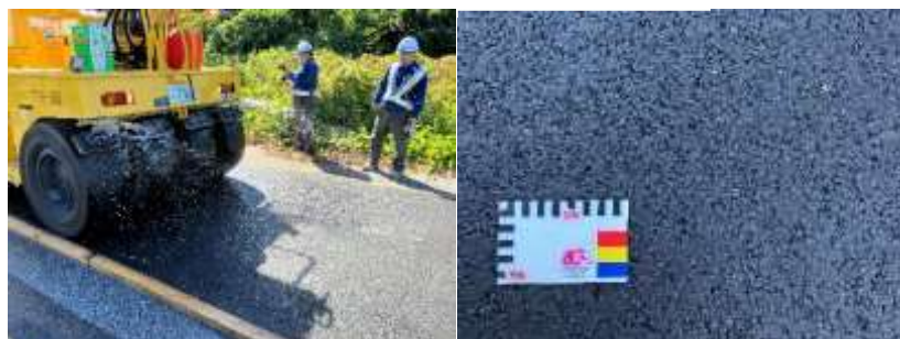
写真-2 転圧状況
