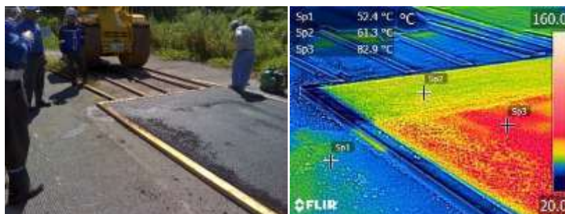
写真-1 敷きならし状況
