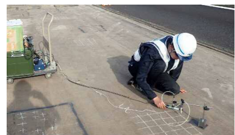
写真-6 RC 床版での打音法による測定
