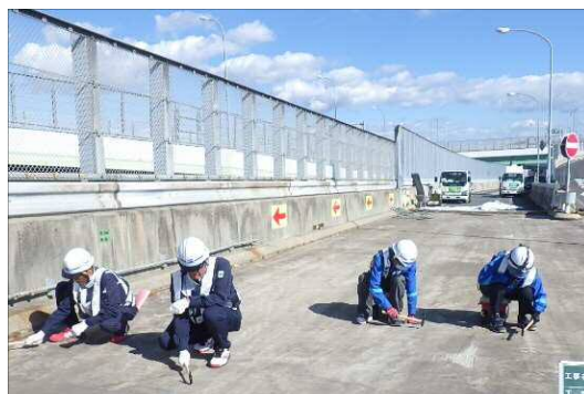
写真-1 RC 床版の打音検査の事例
