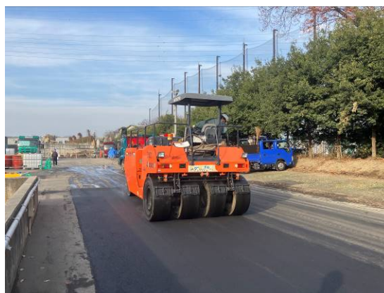
写真-2 バイオ炭混合物の施工状況
