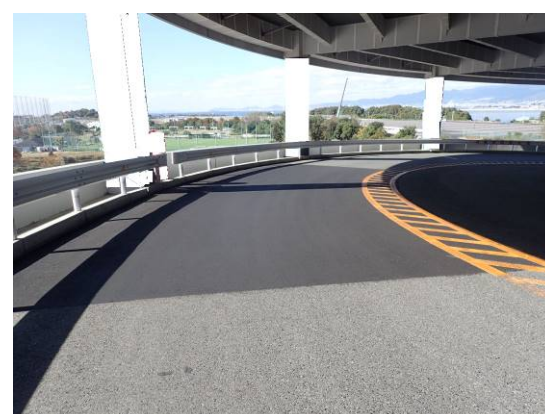
写真-4 施工完了状況
