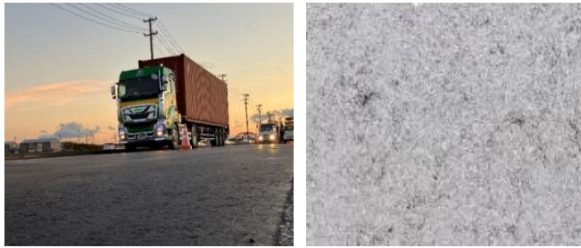
写真-2 完成写真（左：外観 右：舗装表面）
