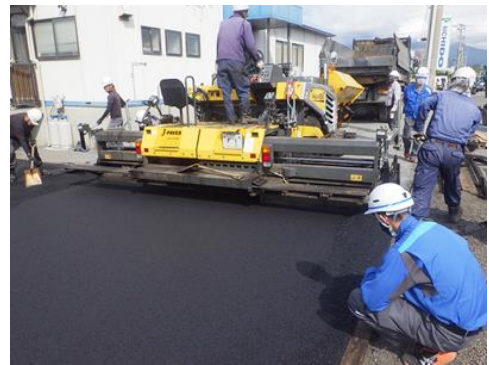
写真2 ストアス工区の試験施工状況
