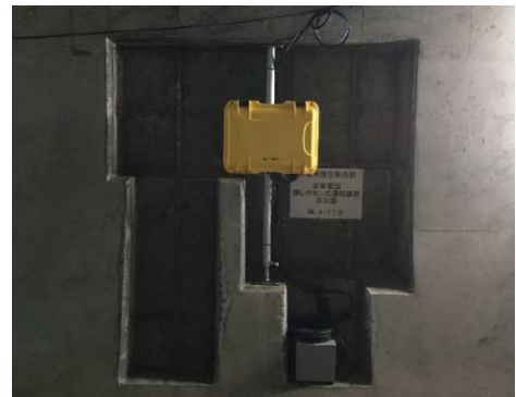
写真-1 トンネル坑内設置状況
