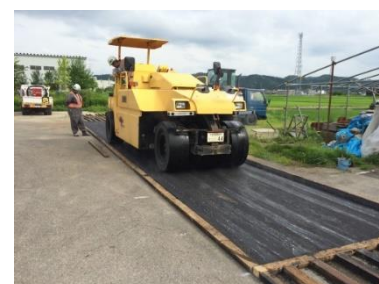
写真-3 施工状況
