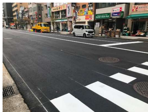
写真-5 完成写真
