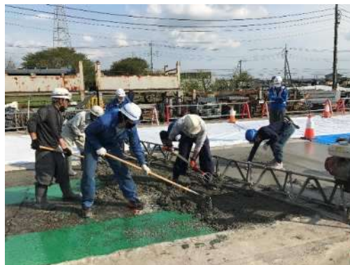
写真2 高強度モルタル敷きならし状況
