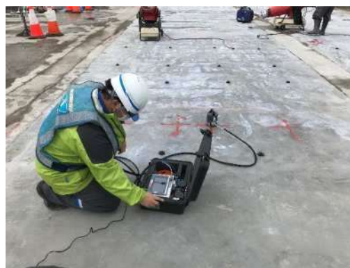
写真 3 表面透気試験状況
