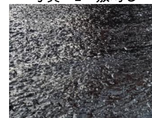
写真-3 仕上がり
