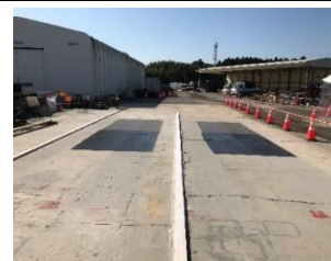
写真-1 敷均し前
