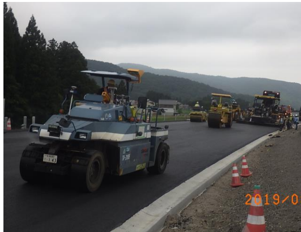
写真-10 高速道路舗装工事の転圧作業
