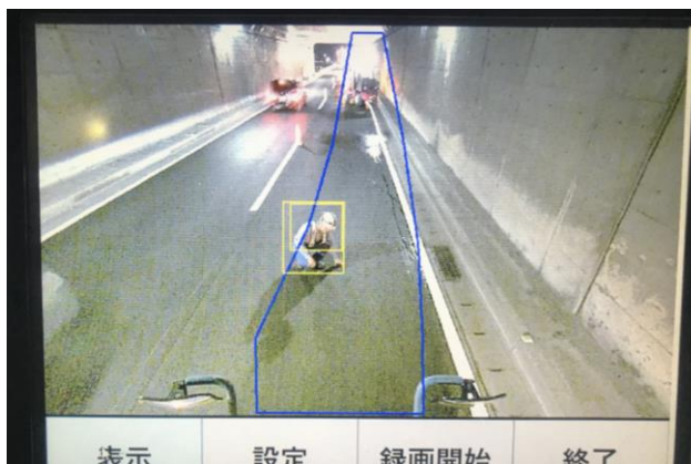
写真-11 夜間修繕舗装工事の検知状況
