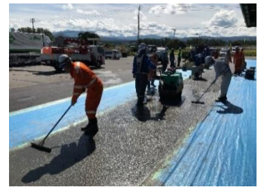
写真-3 セメントミルク注入状況
