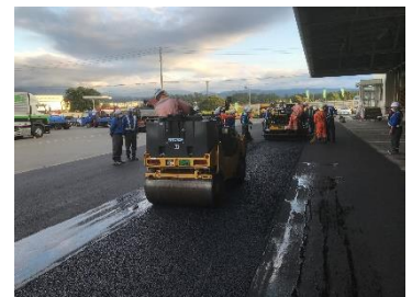
写真-2 母体混合物施工状況
