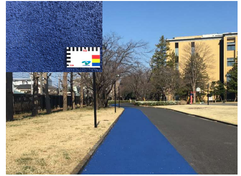
写真-1 完成後の路面
