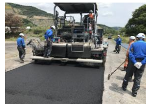
写真-3 施工状況
