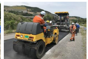
写真-4 転圧の状況
