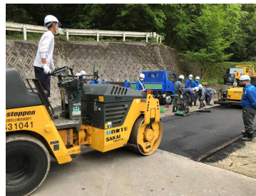
写真-2 施工状況
