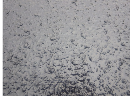
写真-2 仕上がり面
