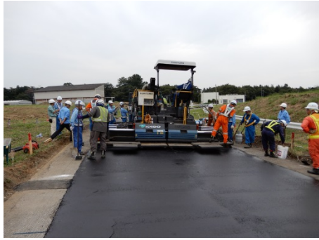
写真-1 施工状況
