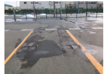
写真-7 施工前の状況
