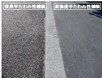
写真-15 供用 8 ヶ月後の状況
