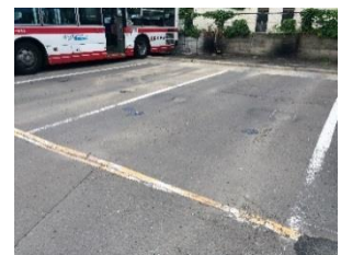
写真-12 施工前の状況
