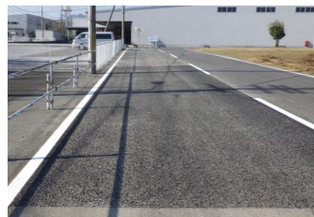
写真-2 施工完了後
