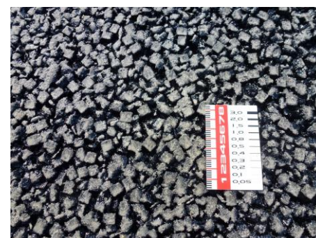
写真-3 舗装表面
