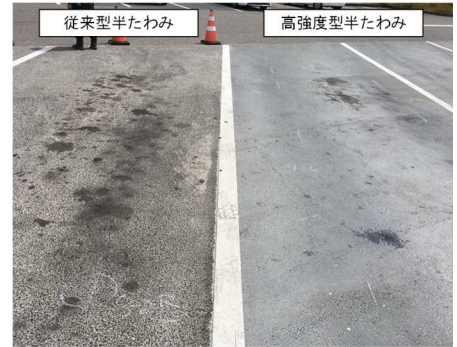
写真-1 路面状況(供用1年)
