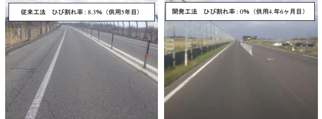
a)従来工法(現場 A) b)開発工法(現場 B)
