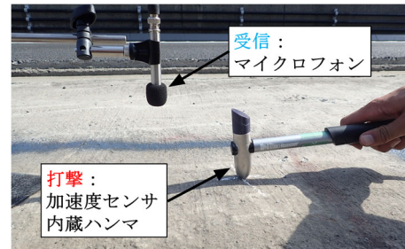
写真-1 打音法による測定状況の一例
