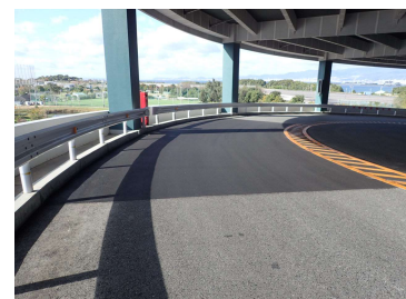
写真-2 舗装の仕上がり
