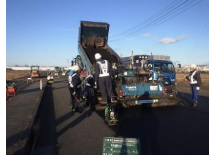
写真-2 施工状況
