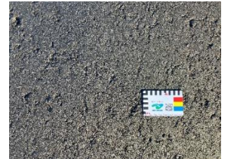
写真-3 仕上がり表面
