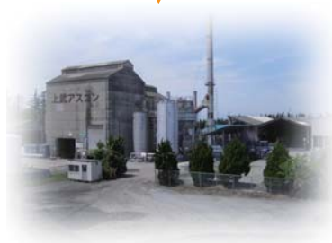
プラントにて新材と合わせて再生合材を製造
