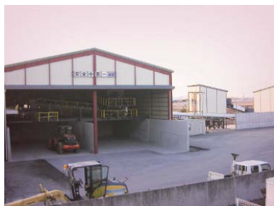
コンクリート中間処理設備
