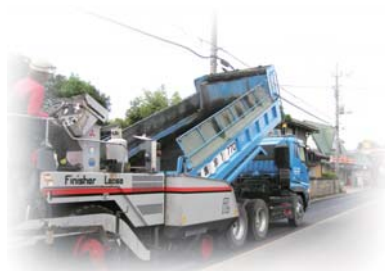
現場にて再生合材を利用して施工
