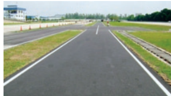
プロトンISO路改修工事 (マレーシア国)
