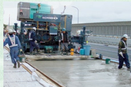
中国自動車道 有野川床版補修工事（兵庫県）
