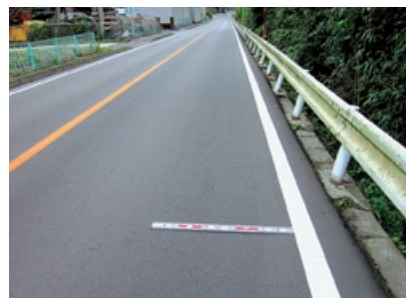
供用1年後の路面状況
