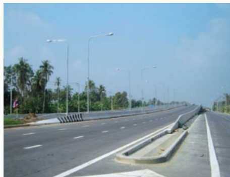
橋梁新設工事（タイ国）
