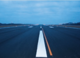
広島空港滑走路改良工事（広島県）
