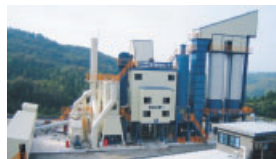
アスファルトプラント(鹿児島合材センター)
