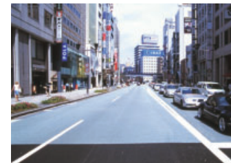
遮熱性舗装（シャットファルト）
