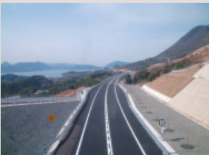
生口島道路瀬戸田舗装工事／広島県
