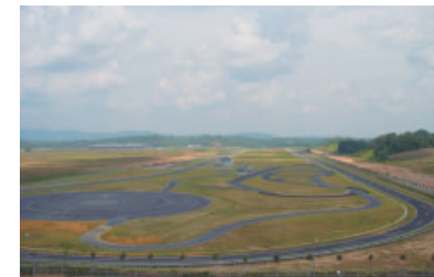
マレーシア国/テストコース新設工事
