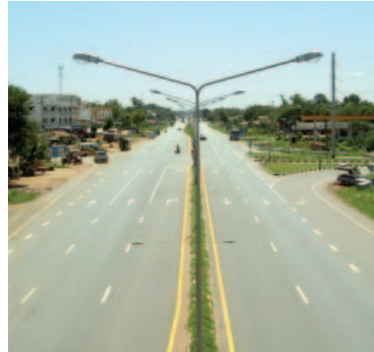
国道12号線コンケン〜ノンル間改良工事（タイ）
