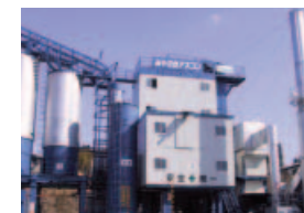
アスファルトプラント（宮崎アスコ）
