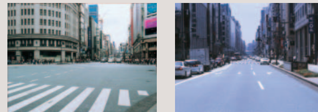
銀座一丁目舗装修繕工事（遮熱性舗装 商品名：シャットファルト）
