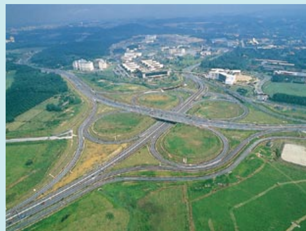
南クランバリー高速道路新設工事1A工区（マレーシア）
