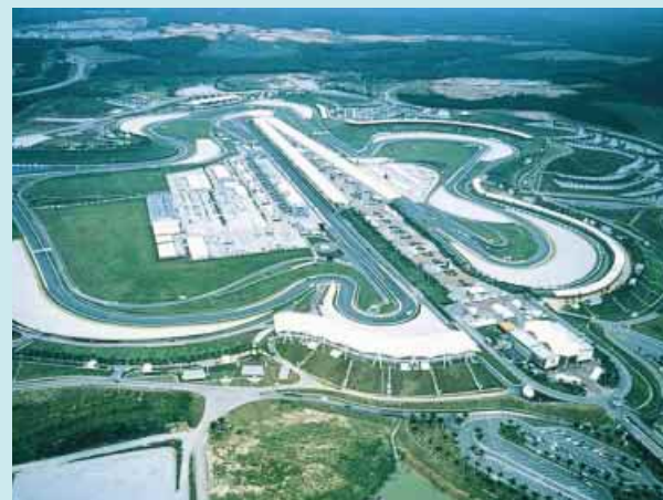
マレーシアセパン フォーミュラワン レーシングサーキット舗装工事
