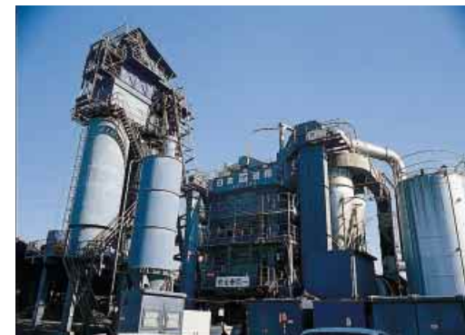
再生兼用アスファルト合材プラント
