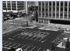
▲「PETアスコン」施工事例 清水建設株式会社 東北支店
