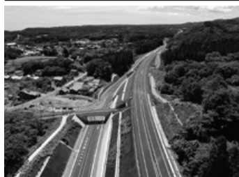
三陸沿岸道路／岩手県
