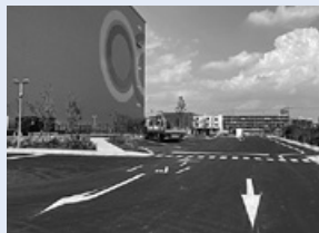
▲「スーパーPETアスコン」施工事例 GLP ALFALINK相模原1
