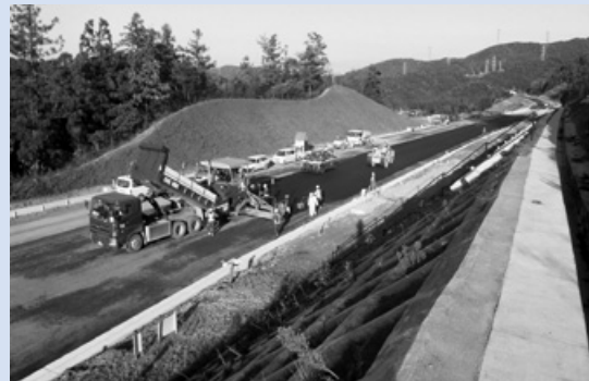
舞鶴若狭自動車道 舗装工事
