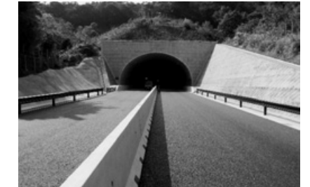
東九州道（県境～北川）古江トンネル北舗装工事（宮崎県）
