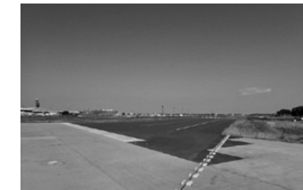
新S5誘導路舗装その他工事（成田空港）
