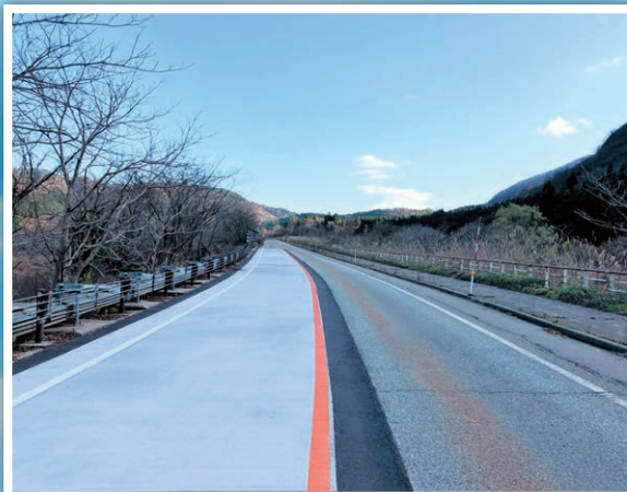
工 事 名：令和5年新発田維持管内舗装修繕工事 発 注 者：北陸地方整備局 新潟国道事務所 工事場所：新潟県岩船郡関川村 工 期：2024年3月12日～2025年1月17日
