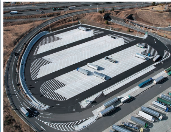
工 事 名：新東名高速道路富士管内休憩施設駐車場拡幅工事（清水パーキングエリア） 発 注 者：中日本高速道路株式会社 工事場所：静岡県静岡市 工 期：2022年8月10日～2025年3月26日
