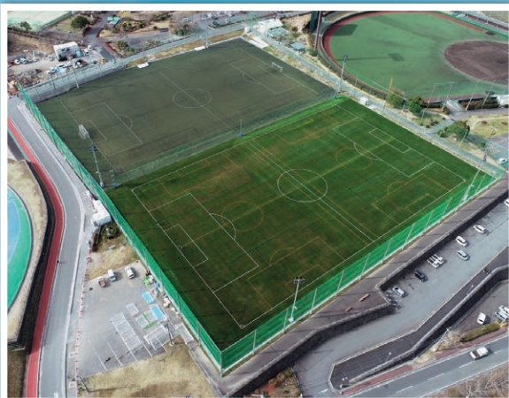
工 事 名：水口スポーツの森多目的グラウンド人工芝改修工事 発 注 者：甲賀市役所 工事場所：滋賀県甲賀市 工 期：2024年9月26日～2025年3月19日
