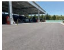
回収した廃PETボトルに化学処理を施した材料を使用したアスファルト舗装です。
