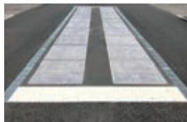
路面に太陽光発電パネルを埋め込むことで、道路を新たな「発電場所」として有効活用することができます。
