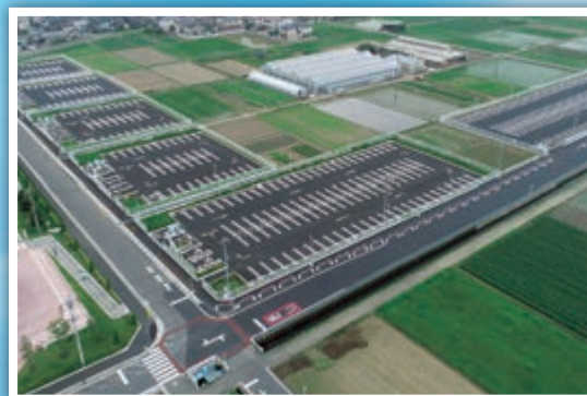
(埼玉石心会病院駐車場／埼玉県)
