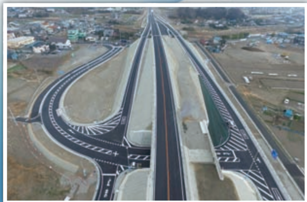
(上武道路 日輪寺舗装その1工事／群馬県)
